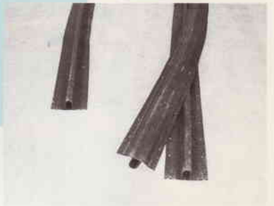
地覆立上り部
