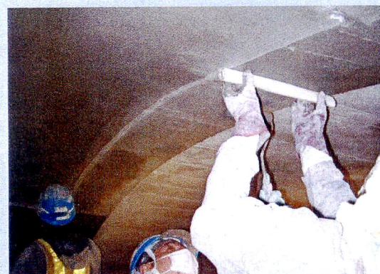
グラスファイバーネットの伏せ込み
